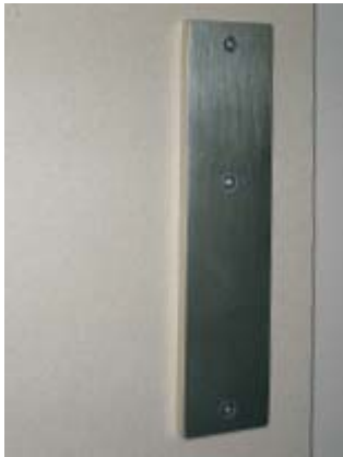
Afbeelding 10: Geen deurblad met uitgefraisd gat voor slotkast en (losneembaar) blind schild toepassen op vluchtdeur met aan de binnenzijde een vlucht- of nooddeursluiting
