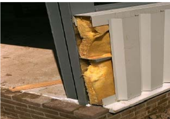
Afbeelding 25 bedrijfshal in aanbouw
