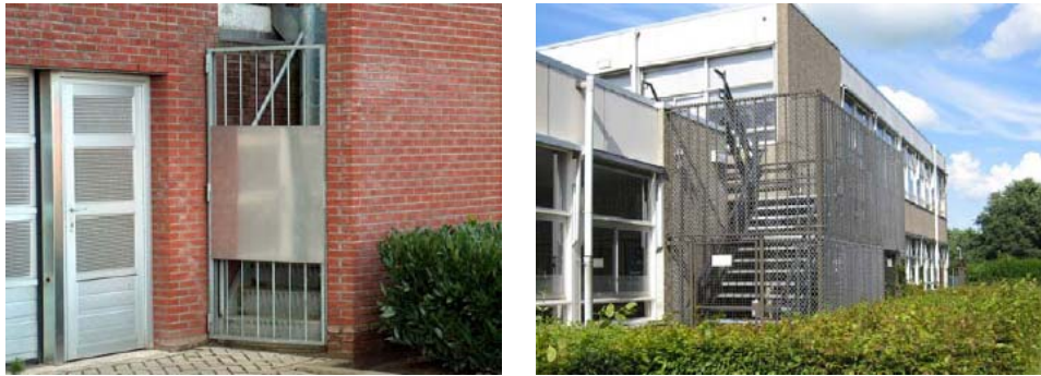
Afb.17 Toegang tot vluchttrappen aan de buitenzijde van gebouwen afschermen. Deuren alleen aan binnenzijde te openen.
