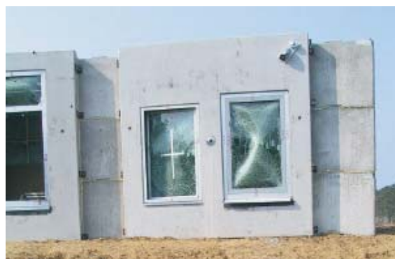
Afb. 27 Twee draai-kiep-ramen, in verschillende hebben de test met goed gevolg doorstaan. Personen in het gebouw zouden ongedeerd zijn gebleven.
