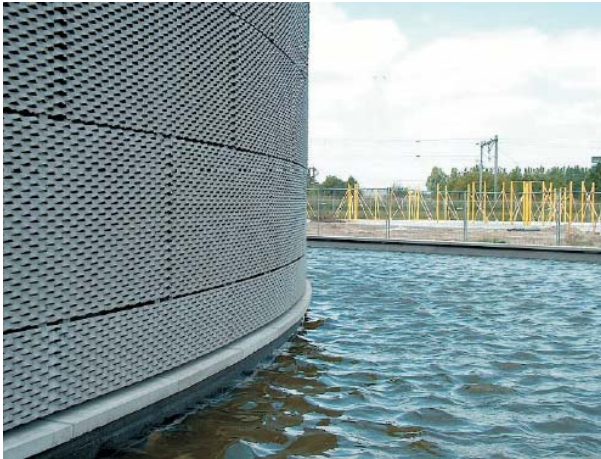
Afb.3 Gracht rond het gebouw en het hekwerk in de gevel
